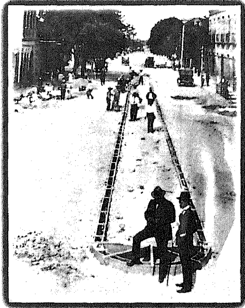
Construcción del camellón de la Av. Morelos entre las calles Cepeda y Rodríguez. Al frente aparece don Nazario Ortíz Garza.
